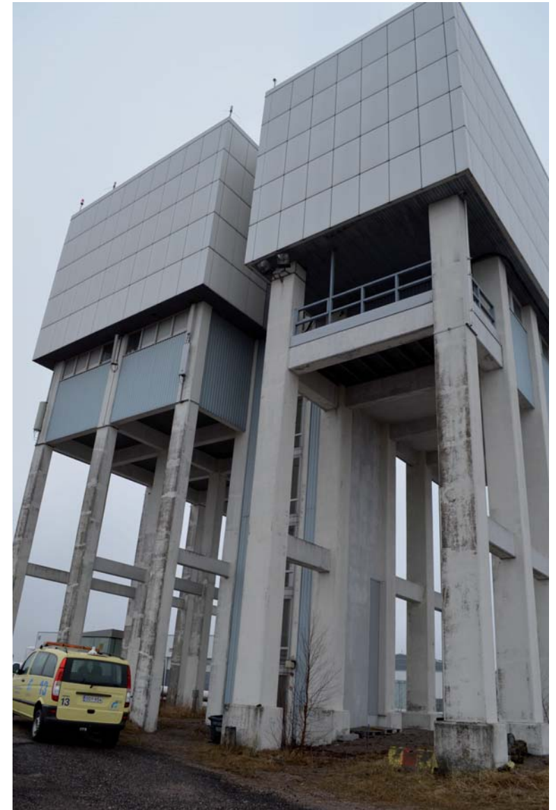
Kuva1. Tutkatorni 2014, laajennusosa vasemmalla.
