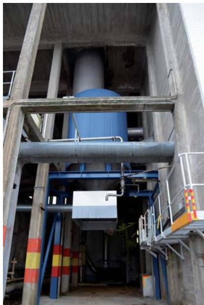
Kuva 20. Uusi hiekkasiilo
